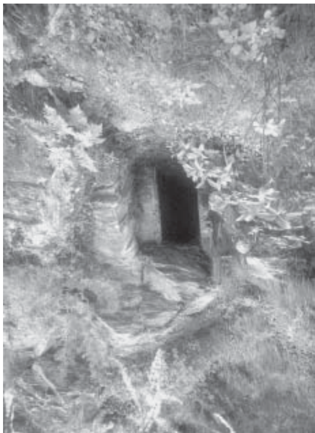
Photo 7: Entrée de la galerie principale de la mine de cuivre de Baicolliou (août 1999).
