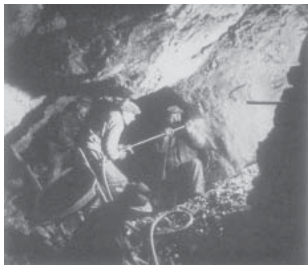
Photo 8: Mineurs au front de taille d'une galerie ascendante pendant la Seconde guerre mondiale. Le filon de minerai de cuivre de la mine de Baicolliou présente un pendage d'environ 25°.
