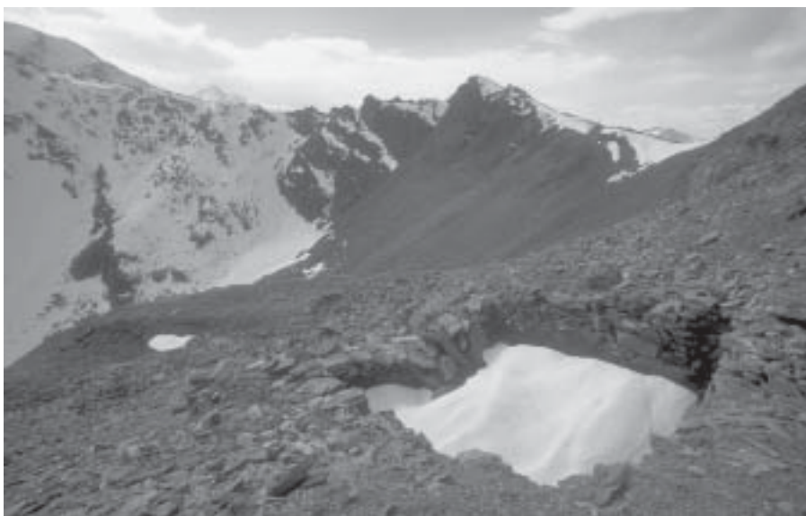
Photo 14: Vue générale vers le sud-ouest de la crête de l'Omen Roso en novembre 2001. Au centre de l'image se trouve la mine de nickel-cobalt de Plantorin, la plus haute de Suisse (3031 m). Au premier plan, les ruines d'un baraquement qui devait vraisemblablement loger les mineurs. Photo: Stefan Ansemet
