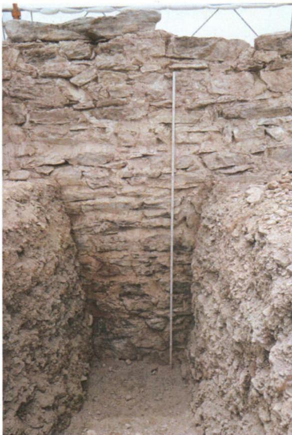
**Fig. 9.** Granges, Bâtie. Sondage effectué à l'arrière de la courtine, dans le local L1. Le parement présente une finition *a pietra rasa* n'ayant aucune trace d'usure, témoignant du remblaiement immédiatement consécutif à la construction du mur. Vue nord-est.
