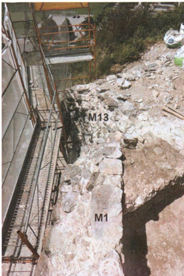
**Fig. 10.** Granges, Bâtie. Le mur de courtine M1 change d'axe à son extrémité nord-ouest (M13). Vue du sud-est.
