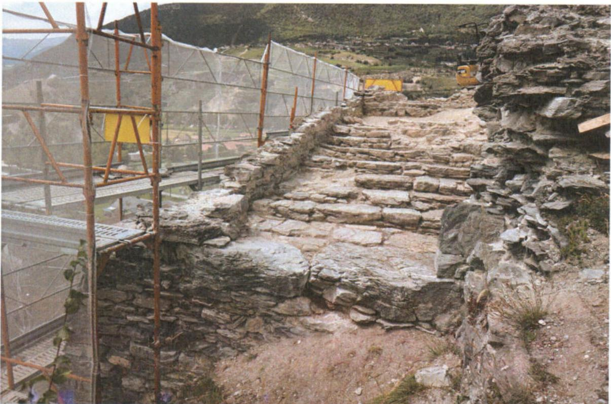
**Fig. 12.** Granges, Bâtie. L'entrée du château. La porte de 1,85 m de largeur comportait deux battants et un seuil composé de deux gros blocs plats soutenus par une maçonnerie chaînée au mur de courtine. Derrière la porte, un escalier permettait de rejoindre le niveau d'utilisation du château. Vue du sud-est.
