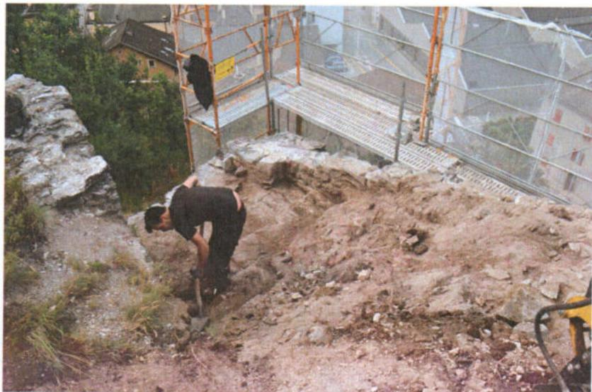
**Fig. 4.** Granges, Bâtie. Les déblais en trop grande quantité sont prêts à être évacués par hélicoptère dans des «big bags» spéciaux pour héliportage.
