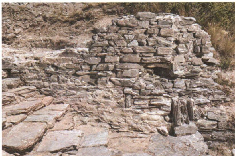
**Fig. 13.** Granges, Bâtie. Mur de soutènement (M5) formant la paroi nord-est de l'escalier. Le piédroit de la porte se manifeste par l'arrachement de la maçonnerie et un reste de la partie inférieure, constituée de pierres posées de chant. Le logement d'une poutre de fermeture est visible à l'arrière du piédroit. Du crépi est encore visible au bas du mur, attestant peut-être que l'escalier était abrité dans un bâtiment, au moins dans son dernier état. Vue du sud-ouest. ©Michel Martinez, 2020.
