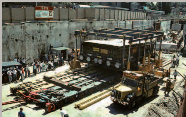
Chargement du caisson renfermant une partie du site magdalénien de Monruz (dimensions du bloc : 6 x 11 m). Le caisson de palplanches est fixé à un portique de levage qui repose sur deux rangées de quatre vérins accouplés prenant appui sur des rails de translation.
